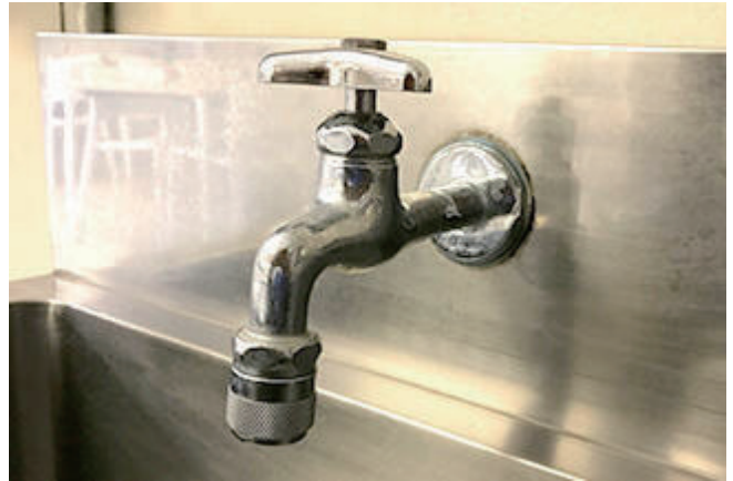
関西工場（滋賀）で導入した節水ノズル
