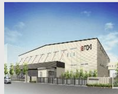
物流倉庫（西日本管轄）
