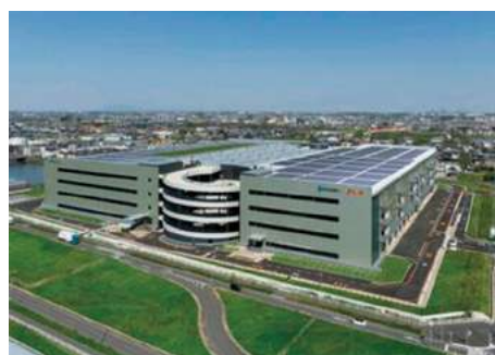
イトーキ東京ロジスティクスセンターが入る物流倉庫
