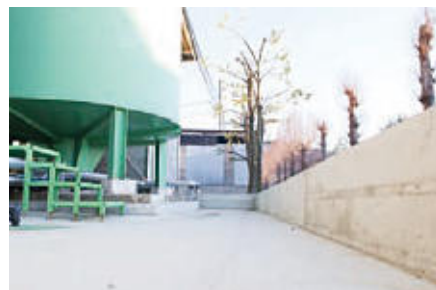
排水処理設備の防液堤
