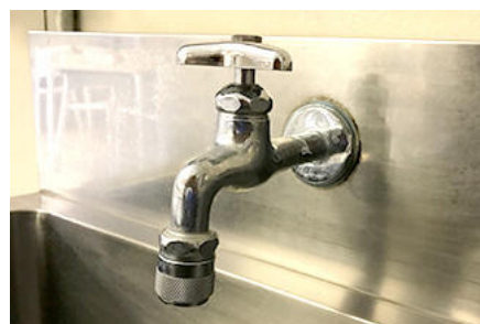
滋賀工場で導入した節水ノズル
