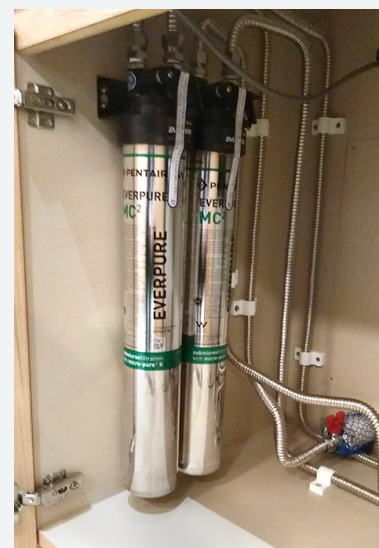
浄水器を設置
