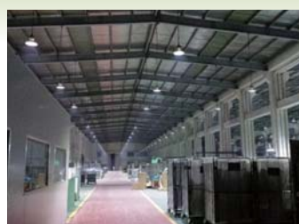
照明のLED化を行った建物内
