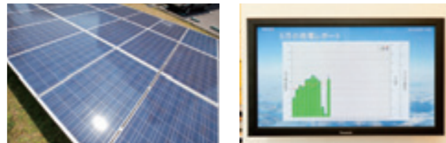
発電能力10kwの太陽光パネル リアルタイムでチェック
