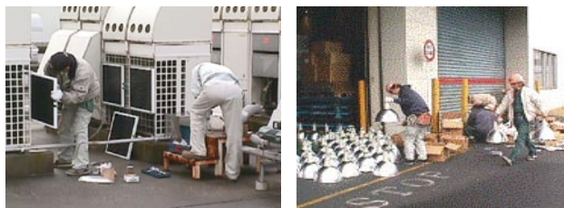
▲省エネルギー工事風景
