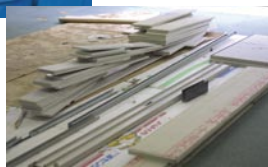
施工現場で発生する残部材
