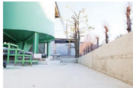
排水処理設備の防液堤
