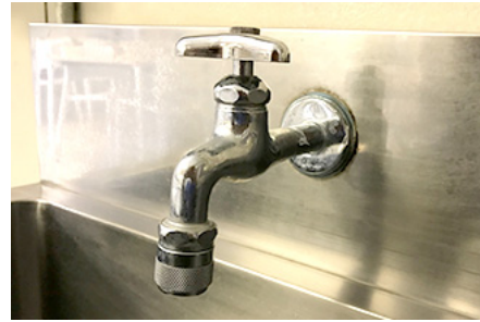
滋賀工場で導入した節水ノズル
