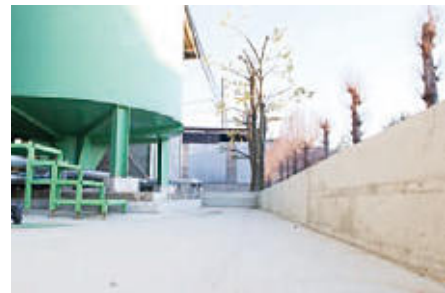
排水処理設備の防液堤
