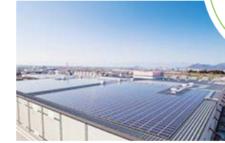
関西工場（滋賀）の太陽光パネル（出力782kw）
