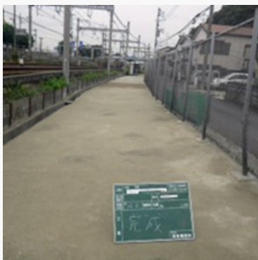
ジオロック防草工事 (北久里浜～久里浜間・下り線防草工事)
