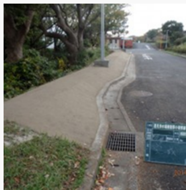
横須賀市逸見浄水場植栽帯小破修繕 (ジオロック施工)
