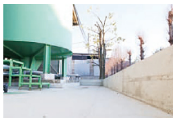
排水処理設備の防波堤
