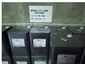
危険物貯蔵庫 積上げ限度を白線で表示
