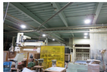
LED照明の導入
